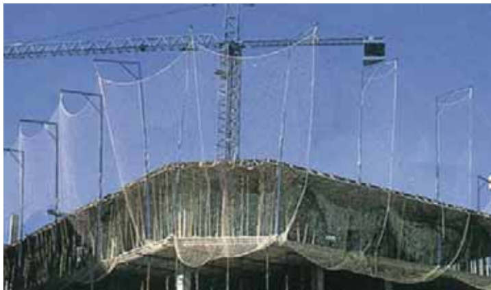
Fig. 9.2.6-1 Esempio di utilizzo di un sistema V (costruzione di edifici)
