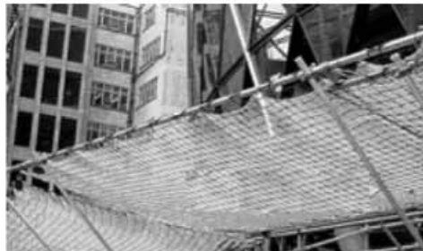
Fig. 9.2.4-2 Esempio di utilizzo di un sistema T (costruzione di edifici)
