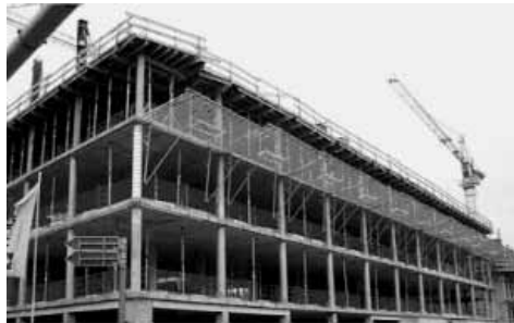
Fig. 9.2.4-1 Esempio di utilizzo di un sistema T (costruzione di edifici)
