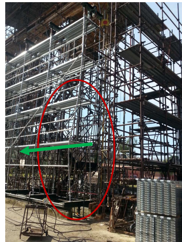
Prova di collasso su prototipo di ponteggio secondo circolare MLPS (full scale) Ponteggio Multidirezionale: collasso nel piano di stilata
