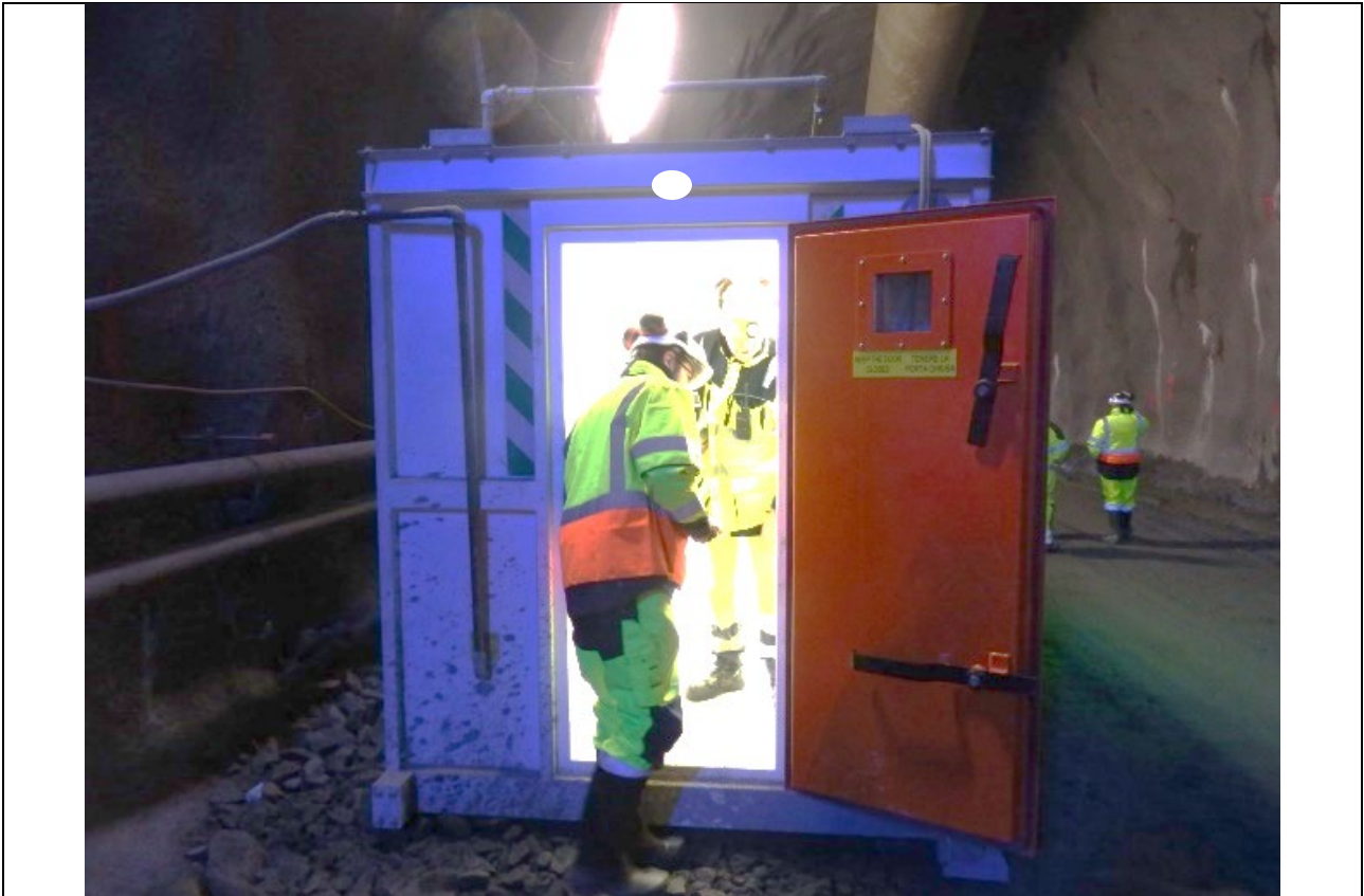
Tipologia di camera di ricovero presente in galleria
