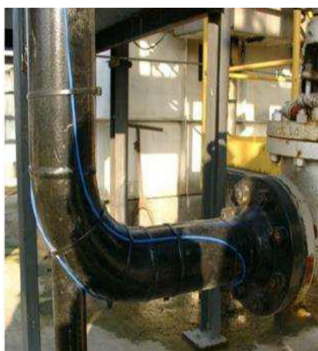
Figura 44 - Fibre ottiche applicate su di un gomito per l'identificazione di possibili rilasci di sostanze
