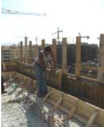
Fig.4.c – Inchiodatura
