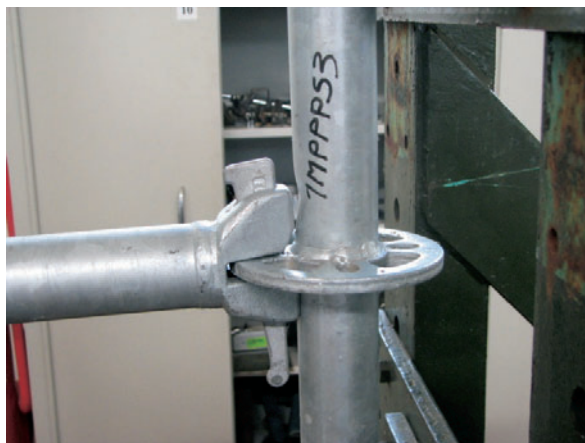
Figura 4.2.2.4-8: Fine prova dopo la rimozione dell'attrezzatura di prova
